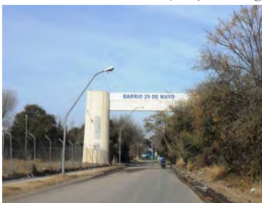
Figura 7 Arco de entrada a los barrios ciudades Fuente: Elaboración propia
